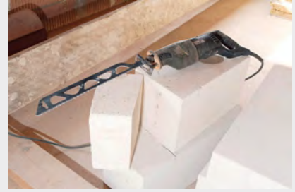
Резка в аэрированного бетона
